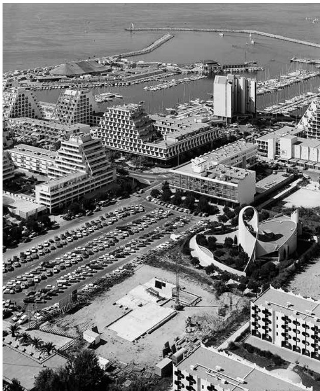
1980, début de la construction de la mairie © Photo Claude O'SUGHRUE n° 8 80 078
