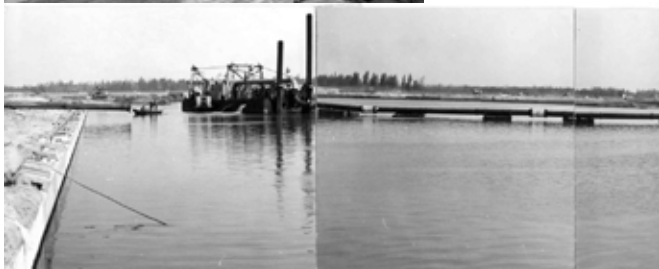
Dragage de l'étang du Ponant, Creusement du Port
