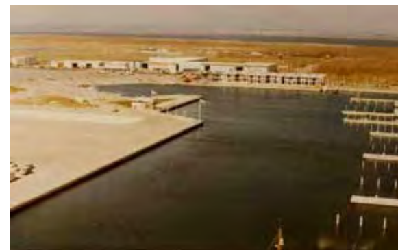
Le quai d'honneur se construit, les appontements se multiplient, la zone de services s'installe (Source Ville de La Grande Motte)
